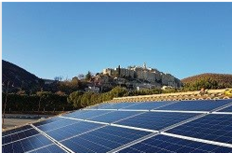
Toiture photovoltaïque du centre de loisirs communal de Banon, mis à disposition des Centrales villageoises Lure-Albion. Source : www.centralesvillageoises.fr
